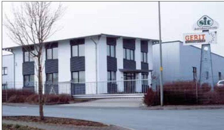
Die Geschäfts- und Produktionsgebäude der SIT-Antriebsselemente GmbH in Brakel / Westfalen.
