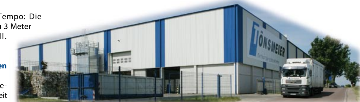
Die Tönsmeier Wertstoffsortieranlage in Oppin in Sachsen-Anhalt.
